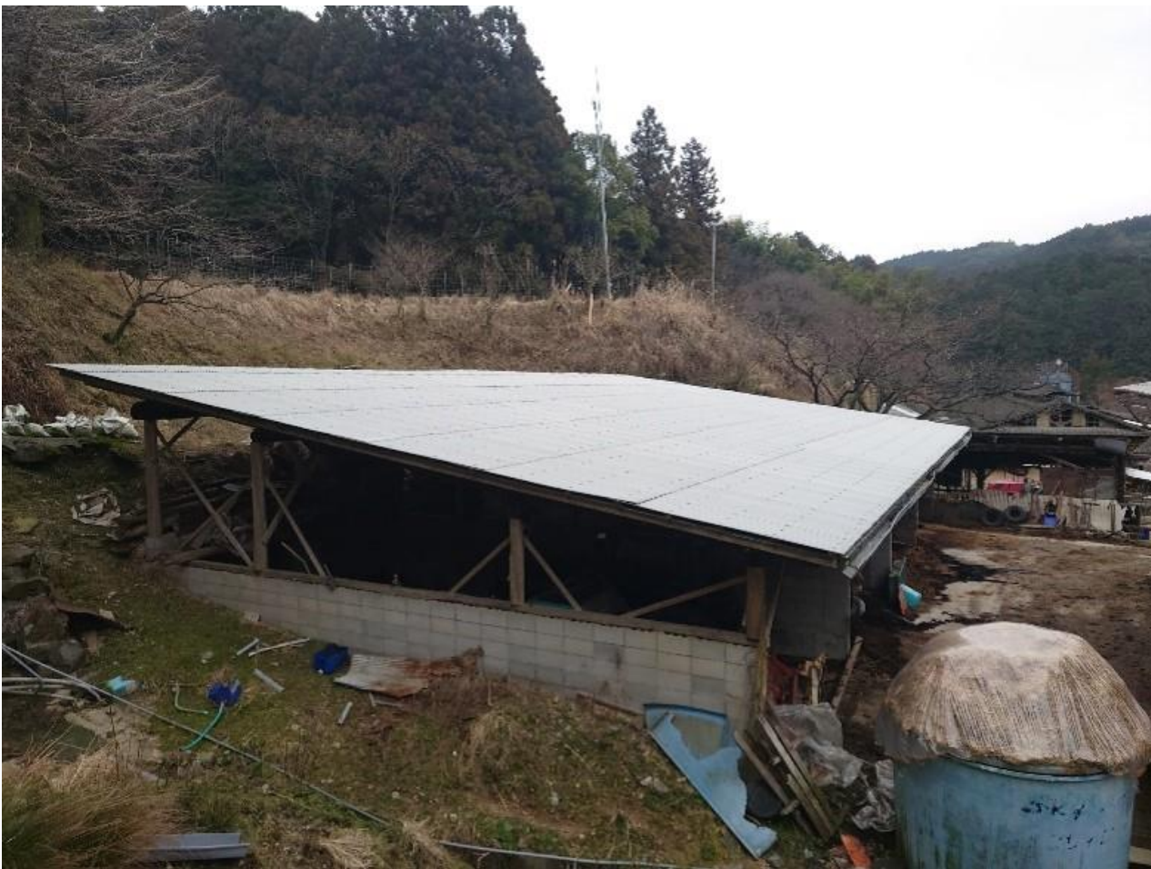
補修後 堆肥舎 屋根部分 上張り補修
